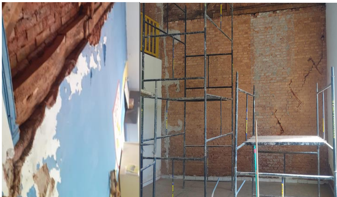
Revitalização e troca do reboco da parede contaminada
